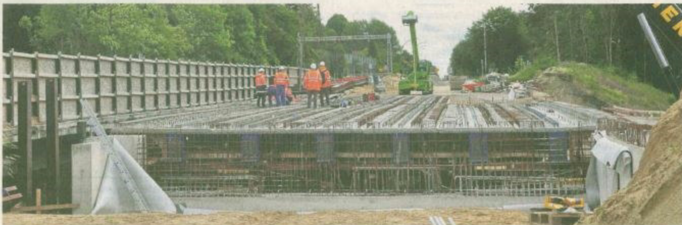
Geschafft: Sämtliche Teile der südlichen B 5-Brücke sind gestern Mittag über der A 1 montiert. In den nächsten Monaten wird betoniert und asphaltiert.
