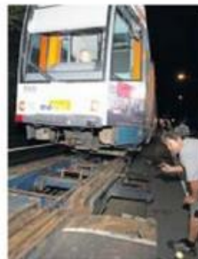
Millimeterarbeit: Über eine Rampe wird die Bahn hochgezogen.
