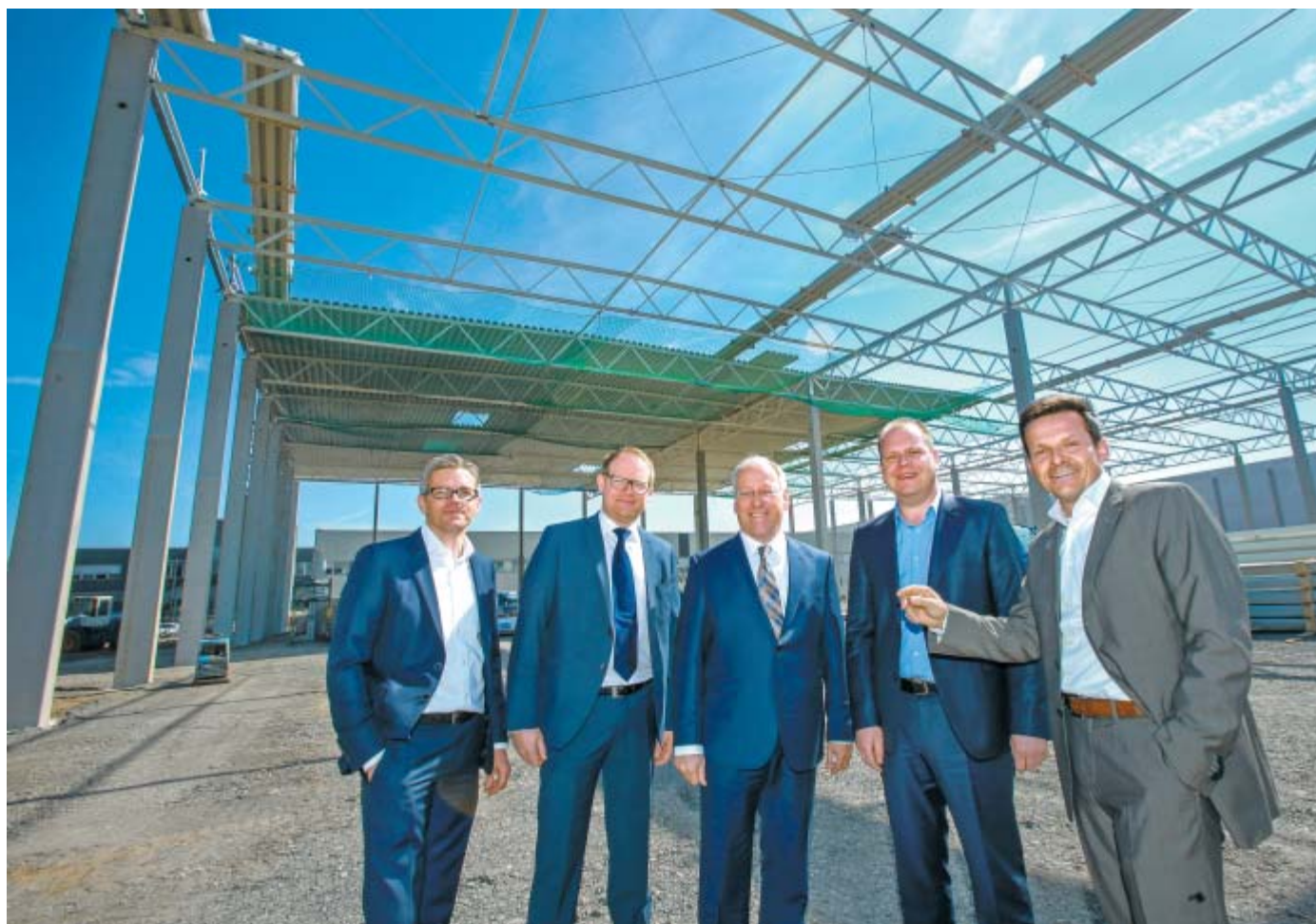
Das Gerüst steht: An der Fuggerstraße begutachten Bernd Jungholt (v.l.), Technischer Direktor von Alpha Industrial, Bezirksbürgermeister Lars Nockemann, Oberbürgermeister Pit Clausen, B+S-Geschäftsführer Stephan Brinkmann sowie Alpha-Geschäftsführer Georg Starck die Baustelle des ersten neuen Logistikzentrums.
