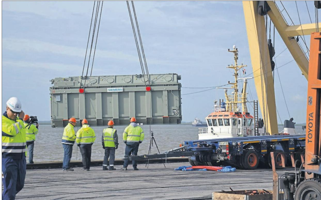
Der 260 Tonnen schwere Trafo für das Brunsbütteler Umspannwerk wird mit Hilfe des Schwimmkrans Enak vom Binnenschiff gehievt. Fotos: Reh
