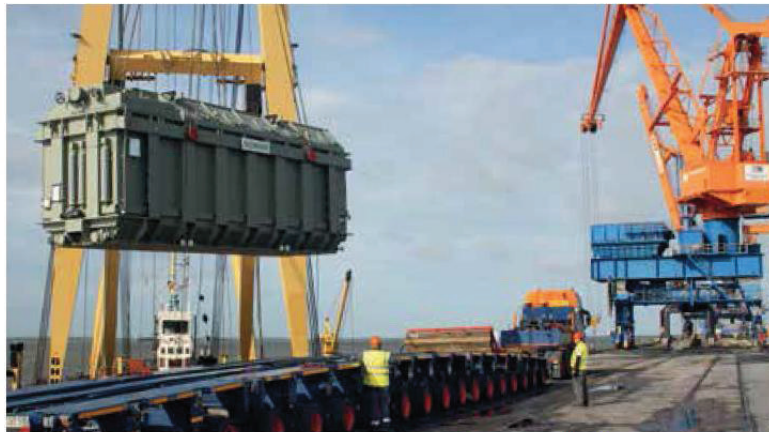
Behutsam wird der rund 260 Tonnen schwere Trafo auf den Spezialtrailer abgesetzt
