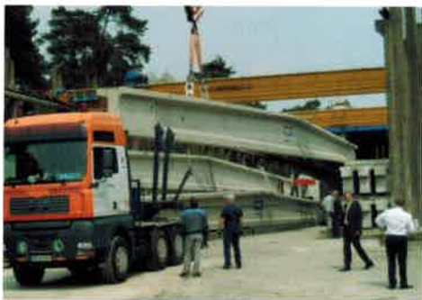
Das Verladen und den Abtransport der 13 Betonbinder verfolgten mehrere hundert Schaulustige.
