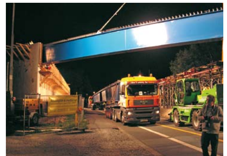
Die Brückenträger für die A33 in Bielefeld werden vom LKW abgeladen und sofort montiert. Unten wartet schon der zweite Träger auf dem nächsten Fahrzeug.
