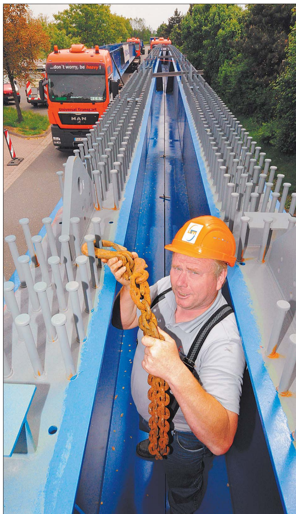
Zwischen den mannshohen und 40 Meter langen Brückenträgern werden ausgewachsene Trucker zu Miniaturen. LKW-Fahrer Gerd Wesenberg wagt sich zwischen die sicher vertäuten »Superklötze« auf seinem Lastzug, um die Dimensionen zu verdeutlichen.
