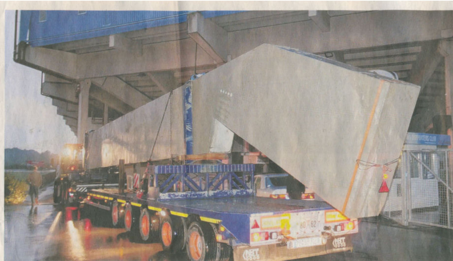
Übergröße: Ein Schwertransporter der Paderborner Firma UTM liefert ein Betonteil für die neue Haupttribüne der Schüco-Arena an. Insgesamt vier Spezial-Lkw führen von Bielefeld-Oldentrup aus in Richtung Innenstadt. Der Transport wurde durch Probleme bei der Beladung und durch das schwere Gewitter aufgehalten.
