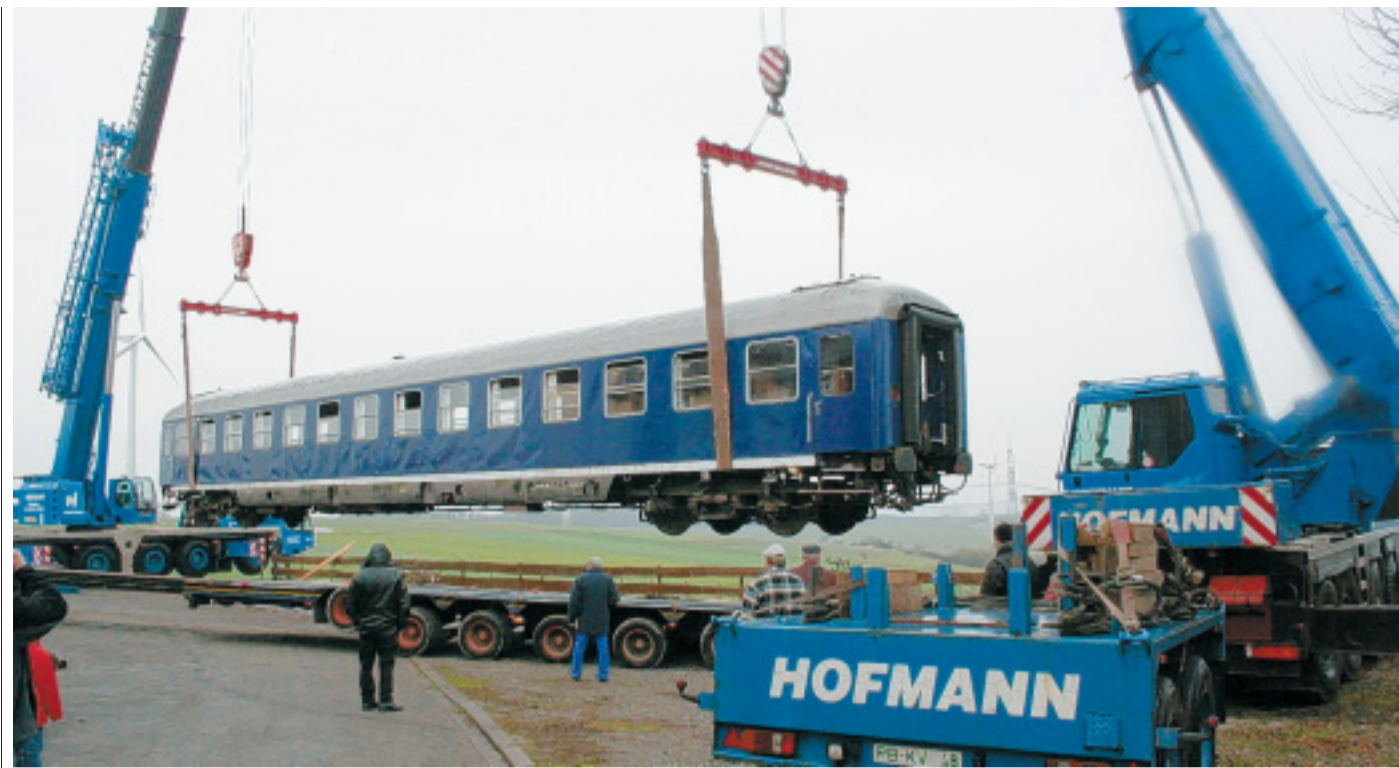
In der Schwebe: Der 40 Meter lange Waggon wird von zwei schweren Kränen vom Transporter auf seinen neuen Standort bei „Silvys Kornhaus-Café“ gehoben. Der Transport von Warburg nach Haarbrück verlief reibungslos in rund einer Stunde. FOTOS (2): SABINE KÜNZEL
