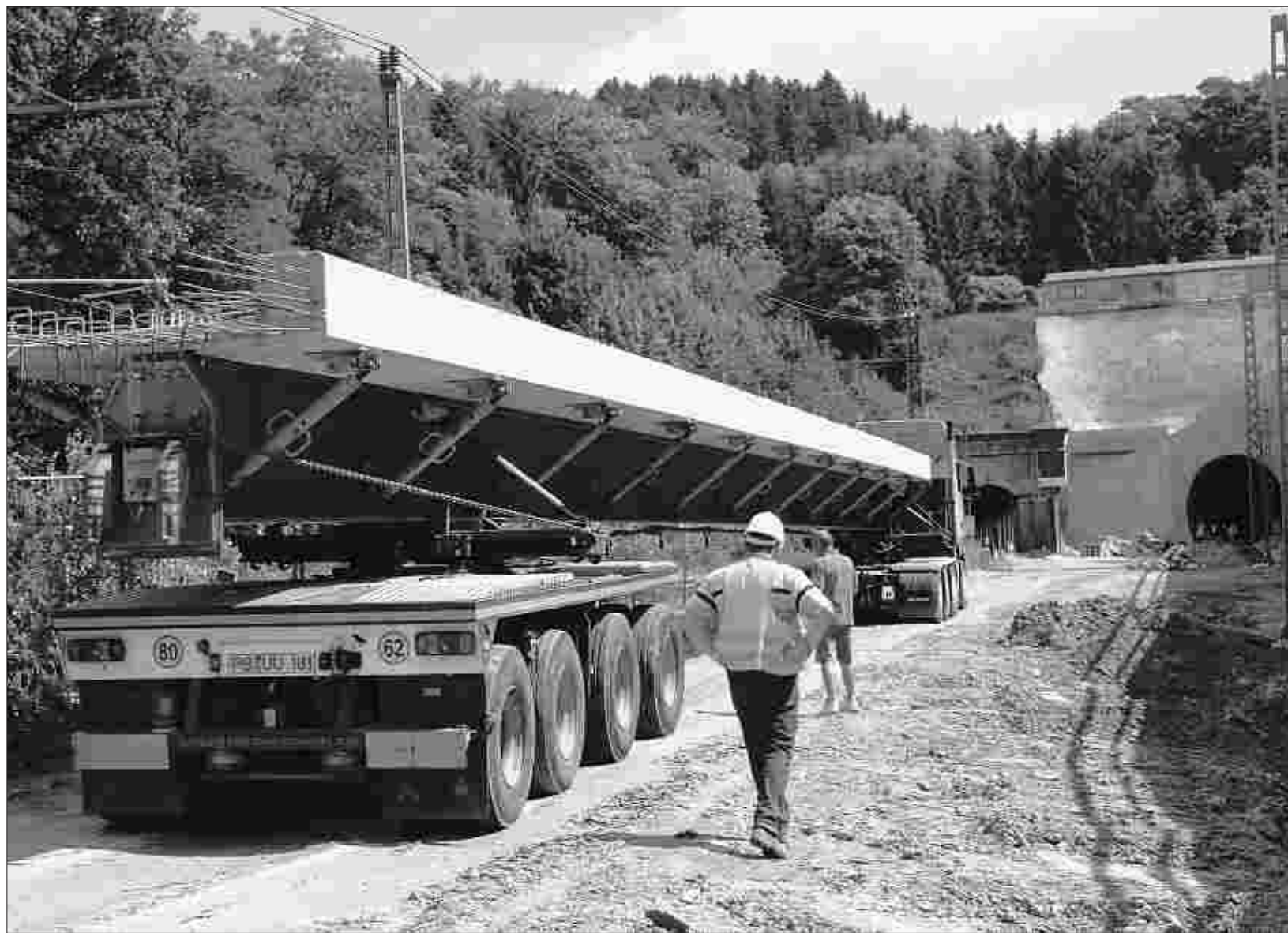
Güterverkehr vor dem Buschtunnel: Mit Schwertransportern kamen zwei Teile der neuen Fußgängerbrücke über die neuen Gleisstränge. Rückwärts wurden die 40 Meter langen Laster durch die alte Zollsiedlung in die Baustelle gefahren. Fotos: Michael Jaspers
