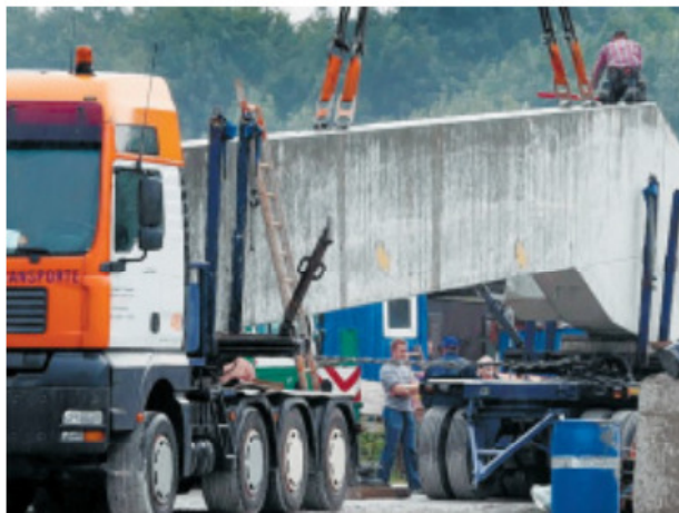
Schwerstarbeit: Per Kran wurden die Betonteile auf dem Gelände der Firma Langenscheidt auf die Lkw geladen.
