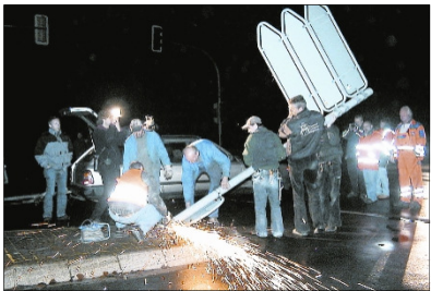
Wenn es sein musste, wurde mit der Flex der Weg für den Brückentransport freigelegt.
