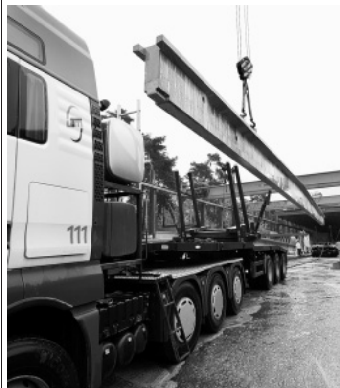
Zentimeter-Arbeit: An zwei Kränen hängend wurden die Binder auf die bereitstehenden Lkws verladen.
