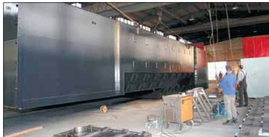
Schwerarbeit war es, den letzten und schwersten Brocken der späteren Schwimmbaggeranlage durch das Tor der Mannschott-Halle zu lenken und auf den Tieflader zu hieven. Foto: Barth
