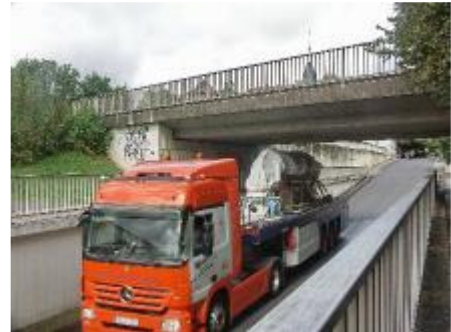
Die Translozierung liegt im Plan. Die Unterführung Felkestraße machte keine Probleme. Foto: Meyer
